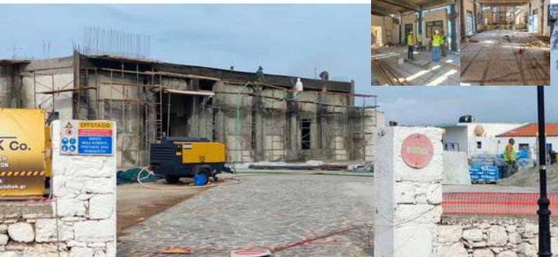
Το Κέντρο Νεότητας υπό επισκευή
